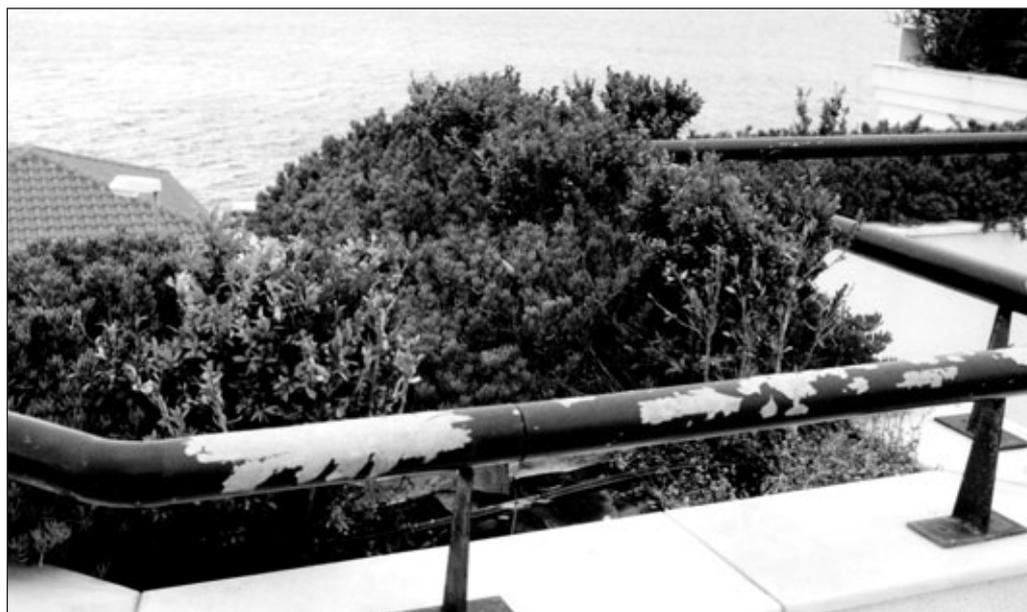
**Korrosionsschaden durch ungenügende Beschichtungsqualität in unmittelbarer Meeresnähe (Korrosivitätskategorie C 5 M).**
