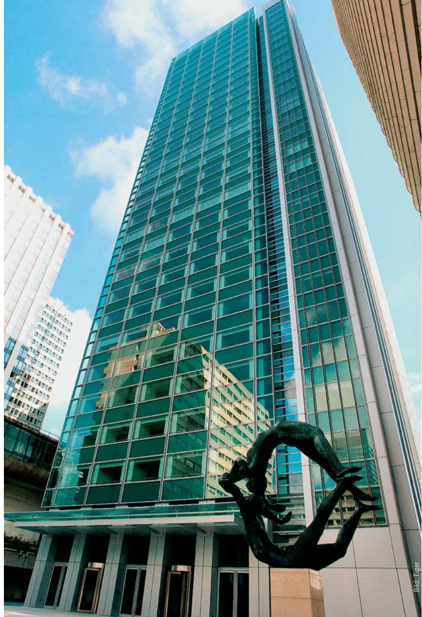
Effekt-Pulverlacke als wichtiges Gestaltungsmerkmal für moderne Gebäude – hier die Fassade des La Défense Tower CB 16 in Paris
